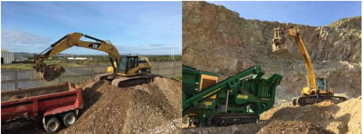
Figure 4. Premiers tests de concassage et chargement de coquilles
