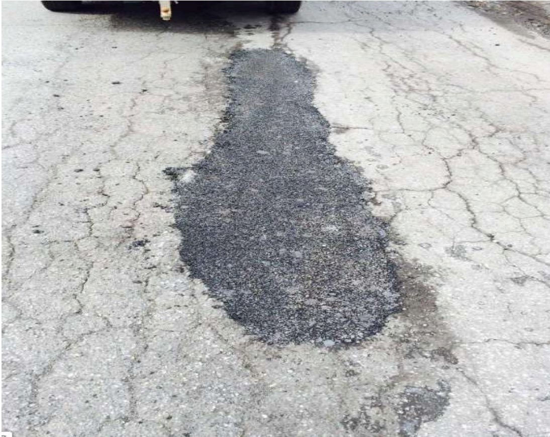
Figure 3. Rapiéçage des nids-de-poule avec mélange contenant des BAPC (Permaroute, s.d.)
