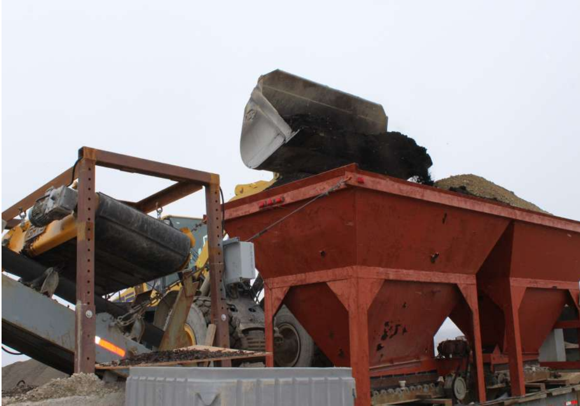
Figure 24. Benne de mélange utilisée pour réaliser le mélange de gravier et de BAPC
