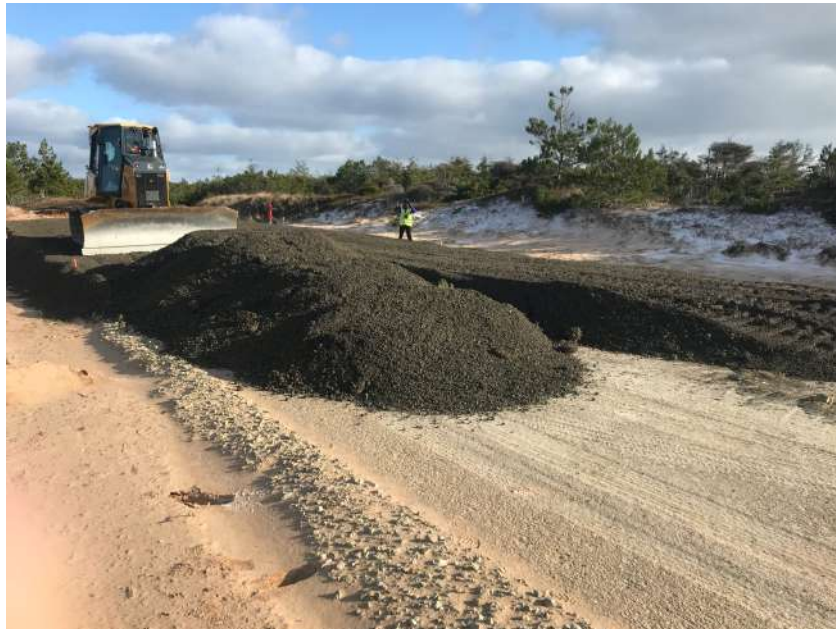
Figure 5.11. Mise en place du matériau granulaire avec 15% de BAPC
