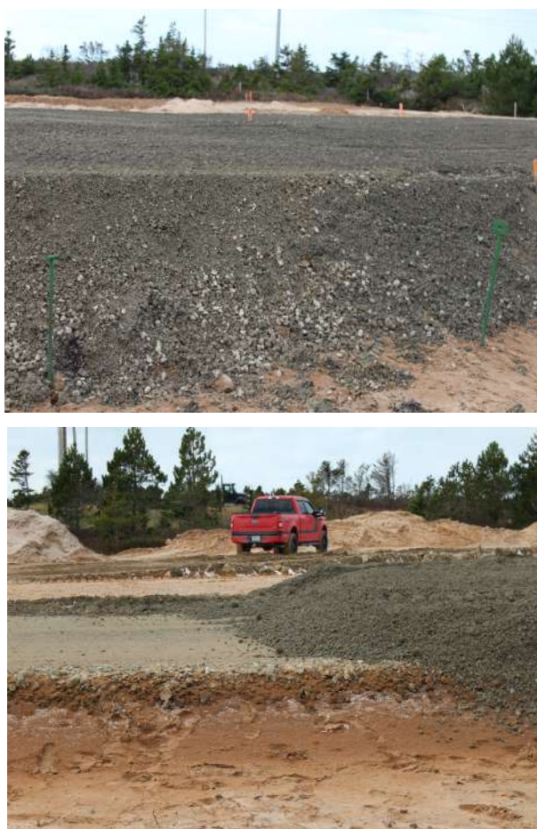
Figure 25. Coupure entre deux planches d'essai
