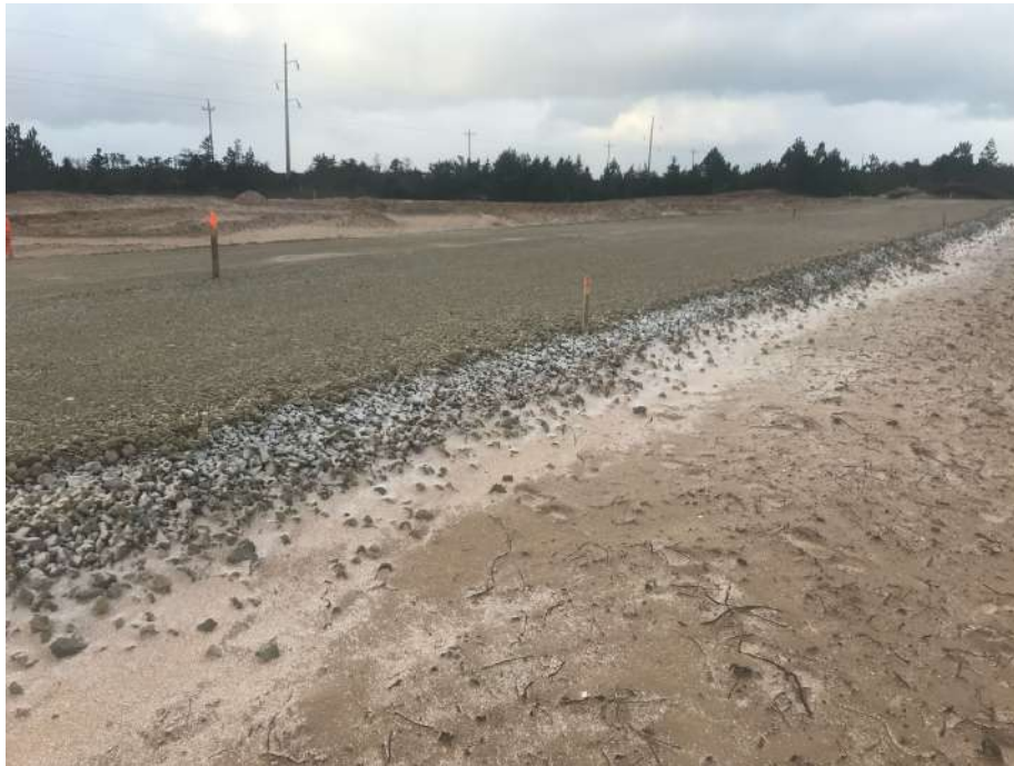
Figure 5.8 Fondation granulaire de la route expérimentale
