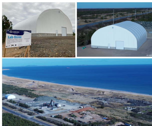
Figure 11. Le LAB-USINE du CERMIM.
