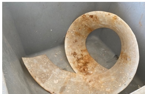
Figure 57. Cône de rétention démonté d'un EPAPR.
