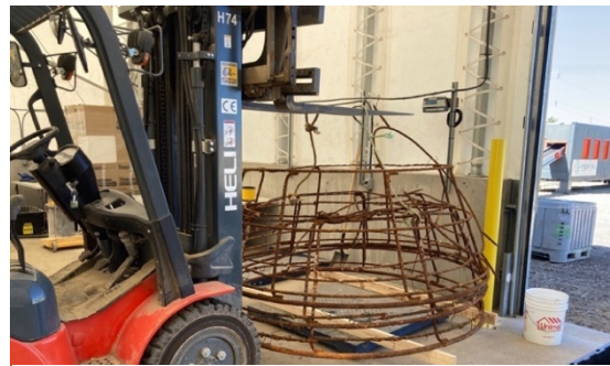
Figure 56. Pesée des structures de métal.
